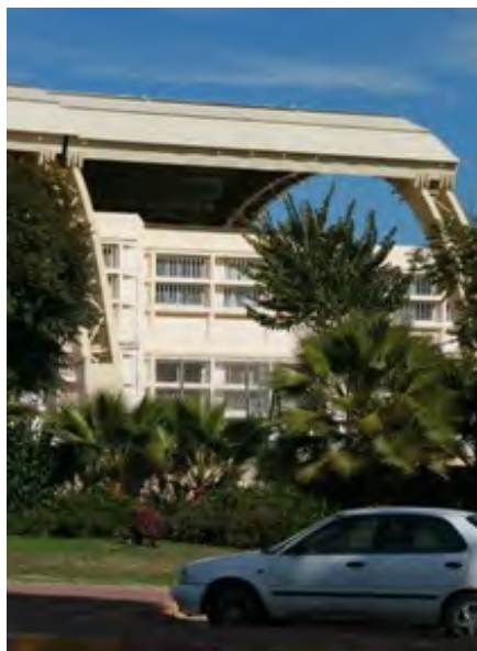
Ecole élémentaire de Sdérot renforcée contre les roquettes
